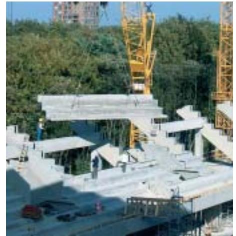
Betonfertigteile im Rhein-Energie-Stadion in Köln
