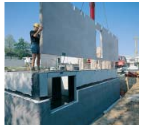
Die Zahl der Eigenheime fiel 2002 auf 173.000 Fertigstellungen.
