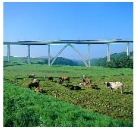
Brückenbau: Ingenieurmäßige Meisterleistung mit Beton
