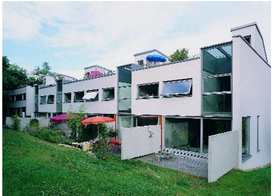
Mit dem Baustoff Beton lassen sich kostengünstige Wohnungen realisieren
