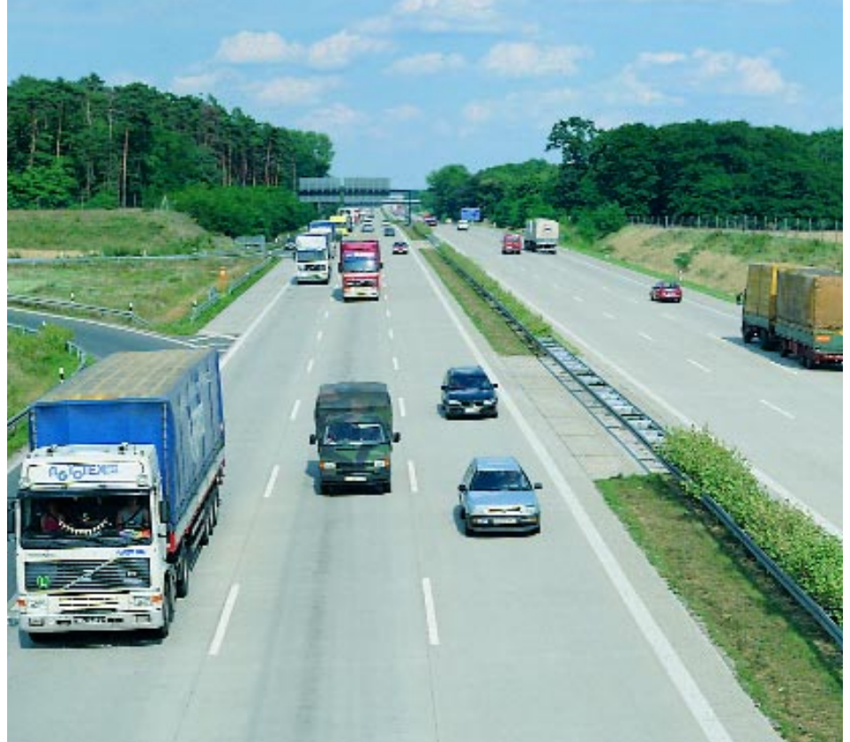
Betonfahrbahnen wie hier im Autobahnbau eignen sich für hohe Belastungen
