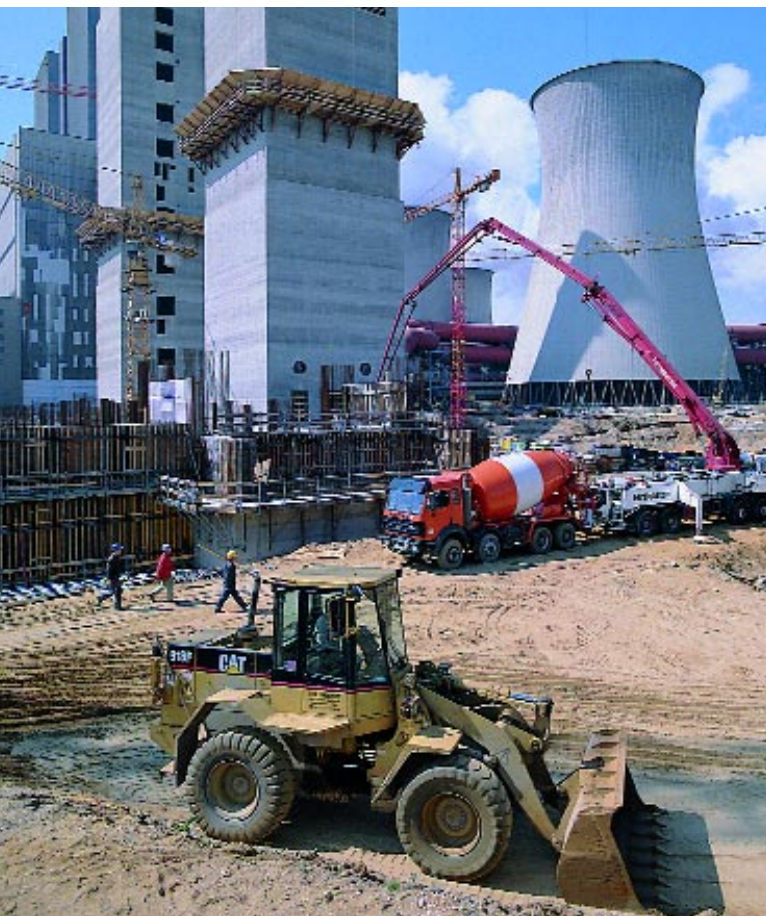
Hochleistungsbeton für den Neubau des Kühlturms in Niederaußem
