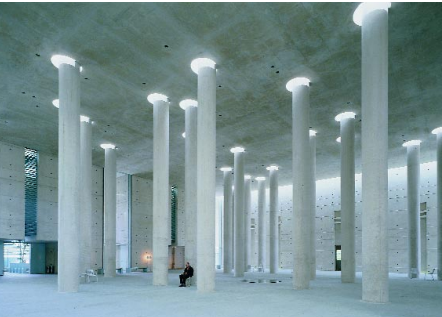
Sichtbeton: Die Säulenhalle des Krematoriums am Baumschulenweg in Berlin-Treptow
