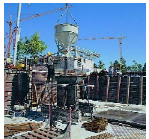
Bau der Wohnanlage „Alter Schlachthof“ in Paderborn
