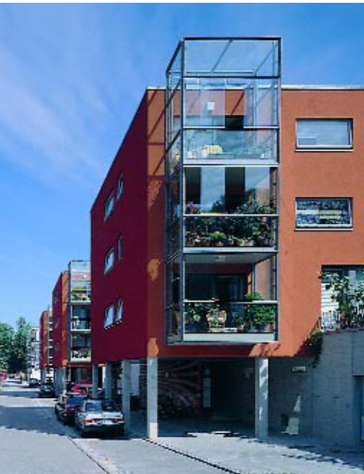
Wohnungsbau in Regensburg-Steinweg
